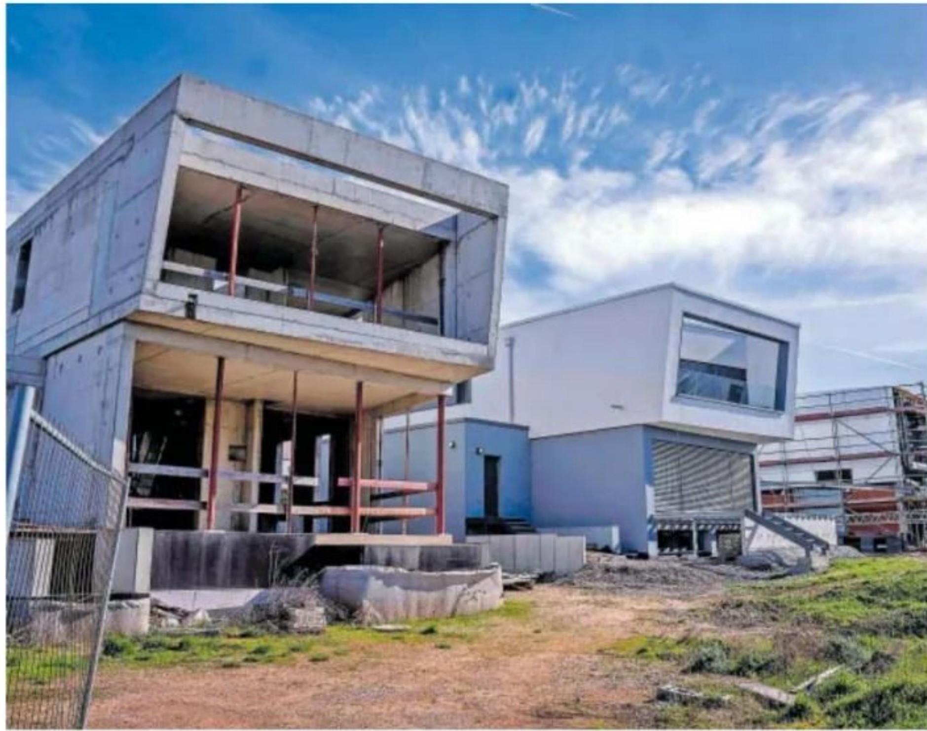
Casas unifamiliares en construcción en Fráncfort. MICHAEL PROBSTT (AP/LAPRESSE)
