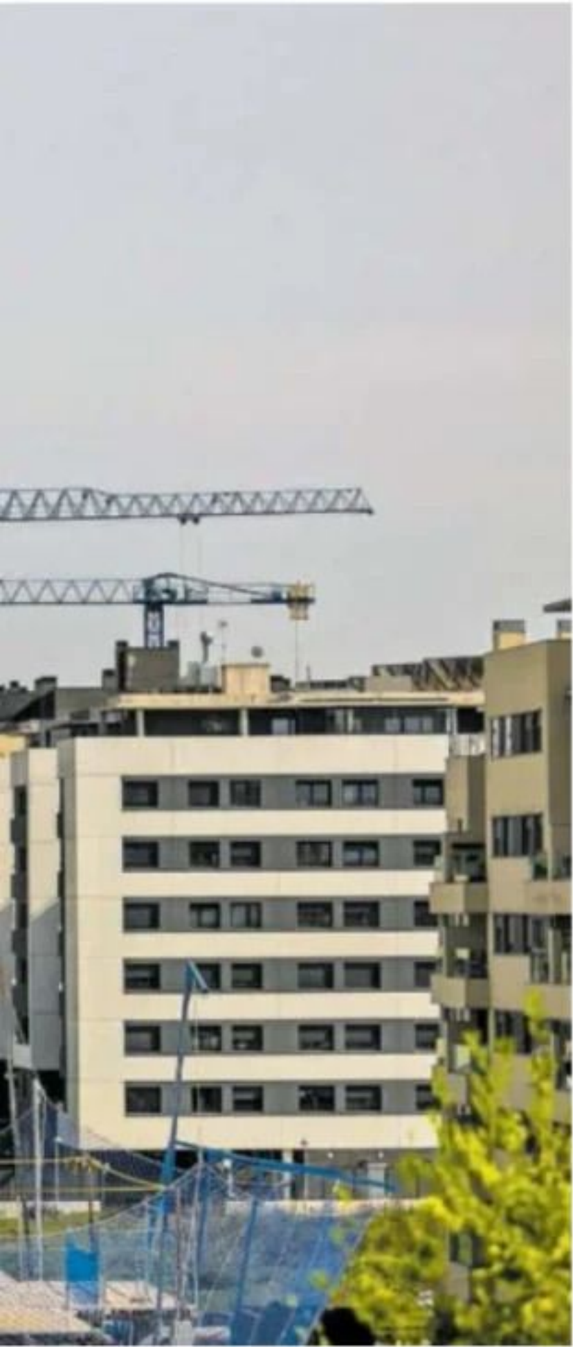
Viviendas en construcción en El Cañaveral (Madrid).
